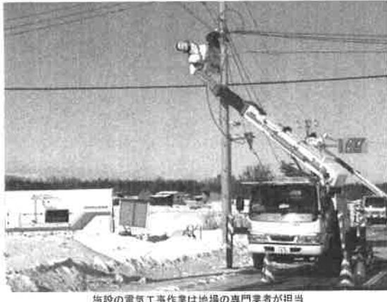
施設の電気工事作業は地場の専門業者が担当
