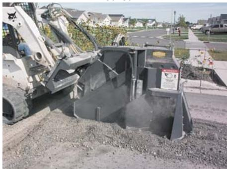
舗装路面の切削、溝掘り
