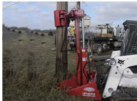
支柱、ポールの埋め込み設置
